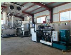
Gasaufbereitungsmotor 200 kWel
