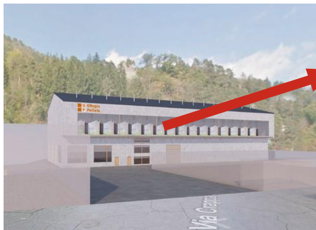
Unten Beton, oben Massivholz: passend zum Ortsbild in Ilanz
